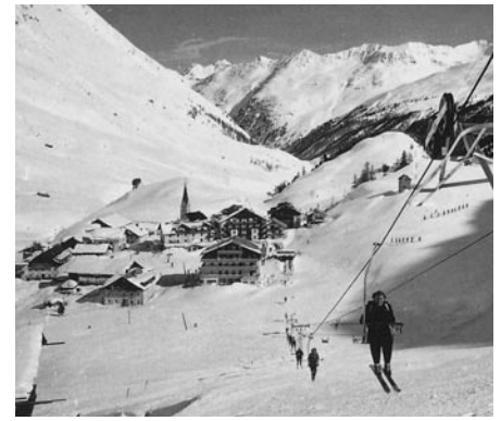
Obergurgl: Auf einem Sonnenhang ließ die Vorstellung eines Mannes ein ganzes Dorf entstehen
